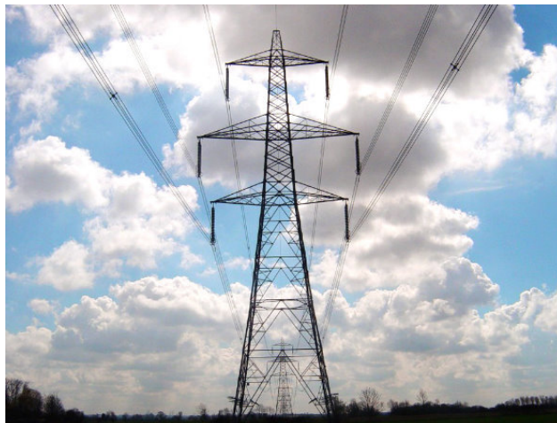
Figura 3.10: Red de transporte de Alta Tensión.
