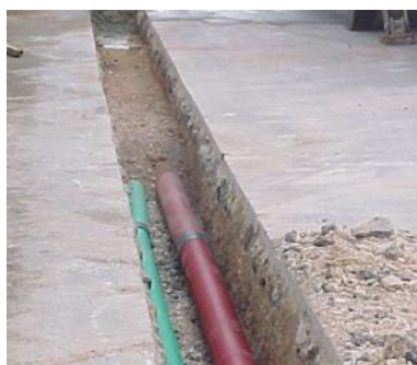
Figura 3.26: Red de distribución subterránea bajo tubo.
