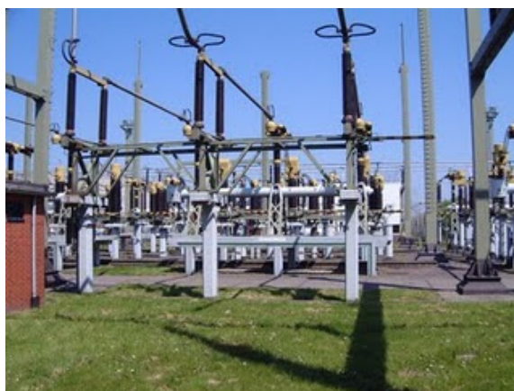
Figura 3.11: Subestación Reductora.
